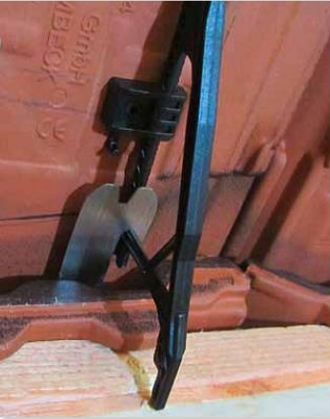
DACHSTICK® nach unten befestigen.
