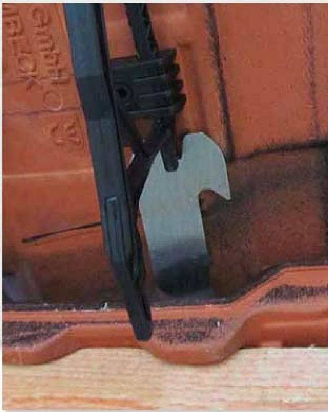
Der Dachstick kann von außen gelöst werden um Arbeiten am Dach vorzunehmen
