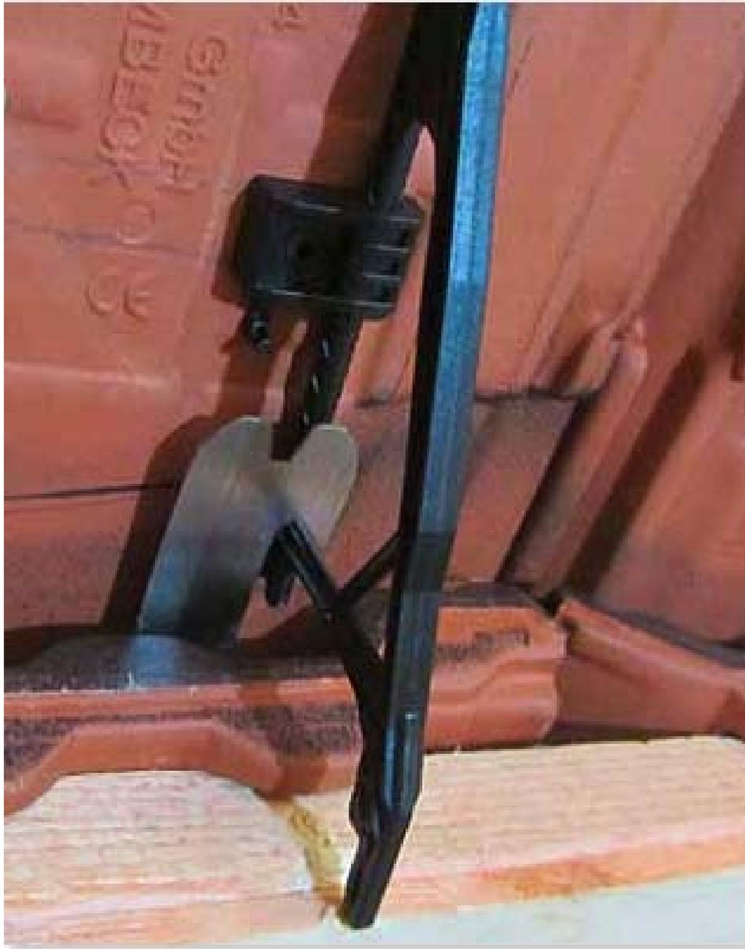
DACHSTICK® nach unten befestigen.
